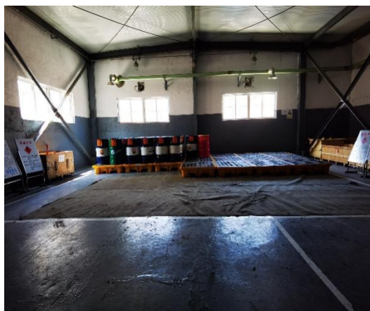
危废暂存间内部
