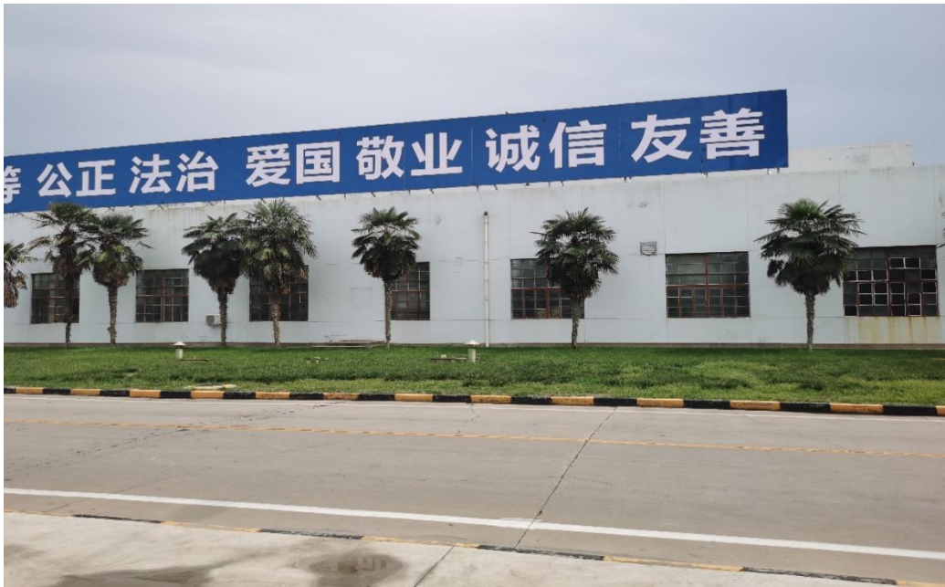
生产车间外部
